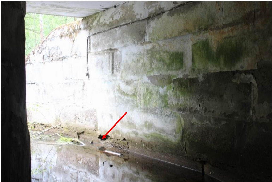
Рисунок Д.4 - Следы увлажнения на внутренней поверхности стены коридора, ведущего с улицы к защитно-герметическим воротам. Механическое разрушение бетона блока стены коридора на глубину до 300мм. Застой воды на поверхности пола
