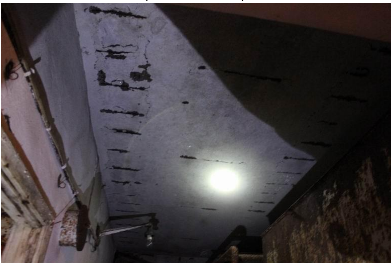
Рисунок Д.31 - Отслоение и разрушение защитного слоя бетона на нижней поверхности плиты покрытия в осях 1-2/Г-Д
