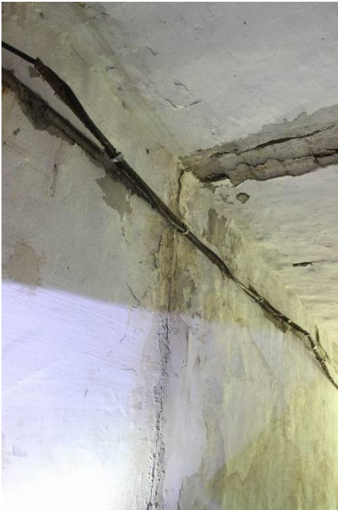
Рисунок Д.10 – Вертикальная трещина в стене в месте расположения вертикального деформационного шва в осях 1.2/В шириной раскрытия до 5,0 мм. Разрушение штукатурного и защитного слоя бетона монолитной плиты покрытия с оголением и коррозией арматуры
