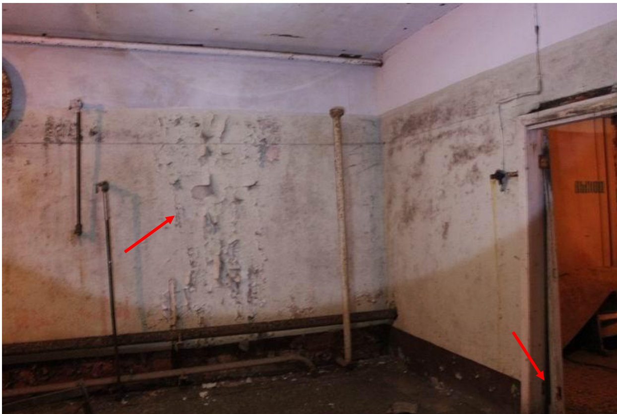
Рисунок Д.13 - Шелушение окрасочного покрытия на внутренней поверхности наружной стены в осях 6/В-Г. Повреждение крепления дверного полотна в осях 5-6/В
