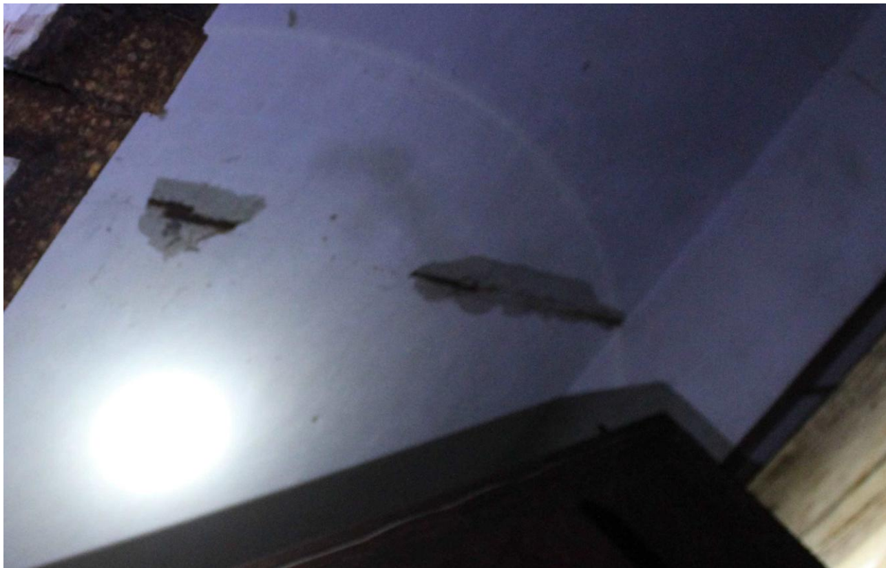
Рисунок Д.24 - Разрушение защитного слоя бетона на нижней поверхности плиты покрытия в осях 6-6.1/Б-В
