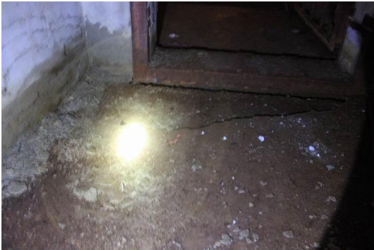
Рисунок Д.1 - Трещина в полу и деформация бетонного пола в осях 6.1-6.2/Б-В, частичное отсутствие грунтов основания пола (пустоты под полом)
