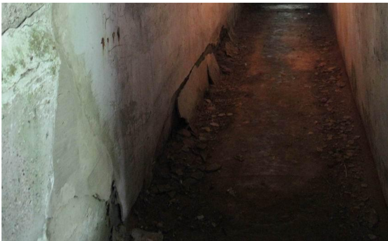
Рисунок Д.7 – Разрушение штукатурного слоя на внутренней поверхности наружной стены на всю толщину в осях 1.2-/Д-Г на площади около 0,8 м 2
