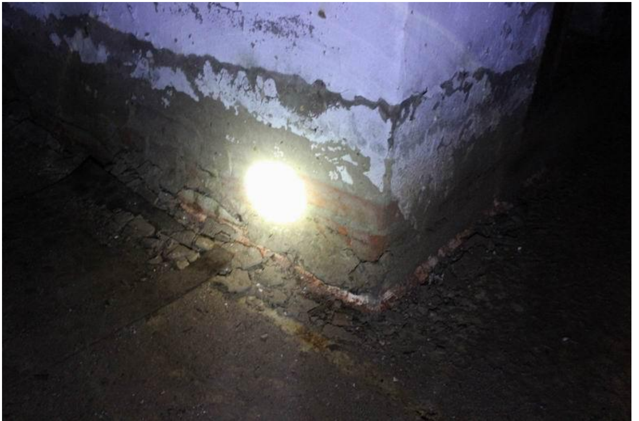
Рисунок Д.17 - Следы затопления убежища на поверхности внутренней стены в осях 5/А-Б. Разрушение штукатурного слоя на всю толщину
