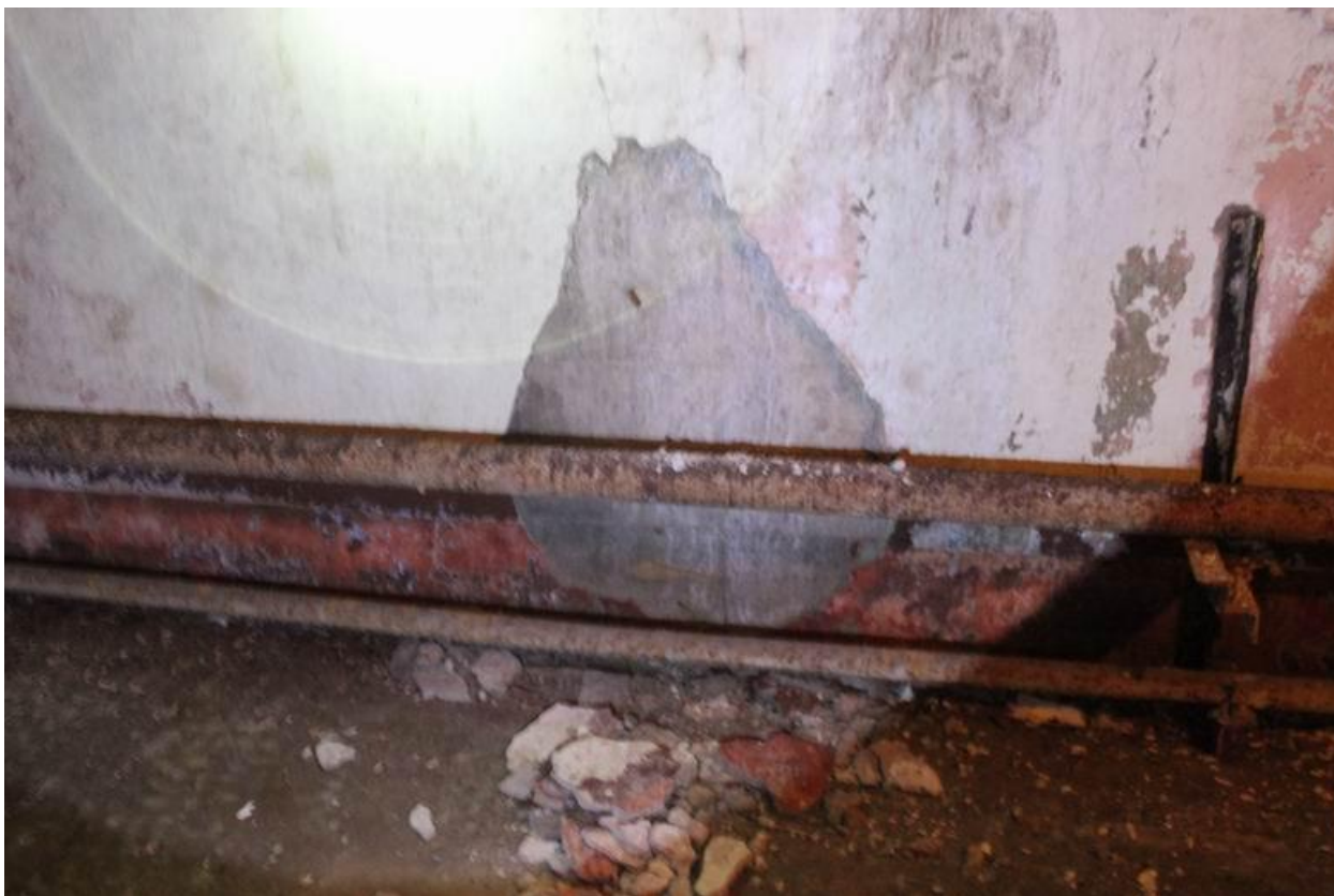
Рисунок Д.14 - Локальный участок с разрушением штукатурного слоя на внутренней поверхности наружной стены на всю толщину в осях 6/Д-Г
