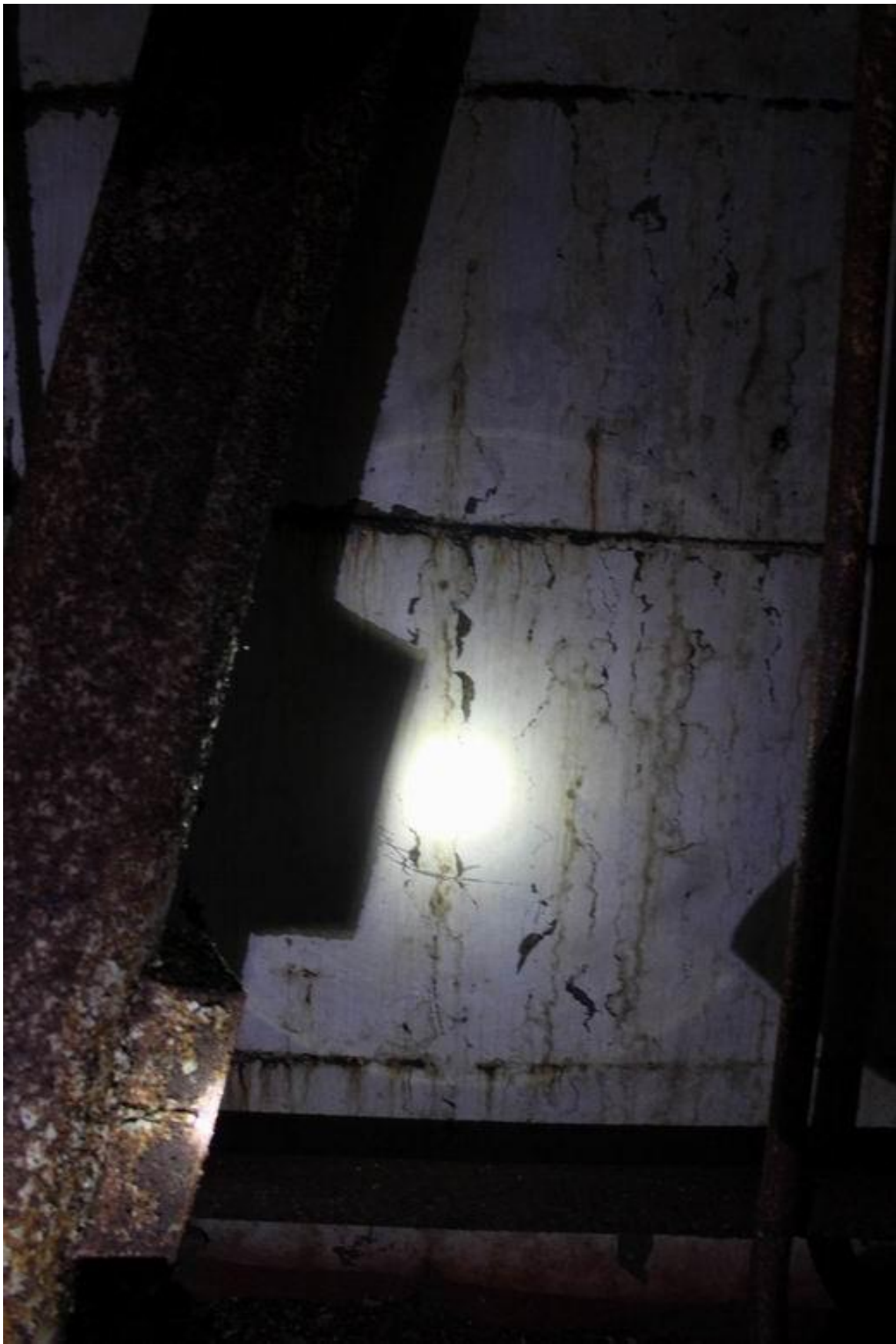
Рисунок Д.11 - Отслоение и разрушение защитного слоя бетона с внутренней поверхности наружной стены в осях 1-2/Д
