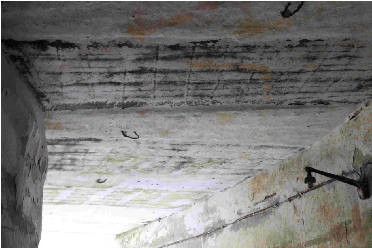
Рисунок Д.26 - Разрушение защитного слоя бетона на нижней поверхности плит покрытия в коридоре, ведущем с улицы к защитно-герметическим воротам. Следы замачивания на нижней поверхности плит покрытия
