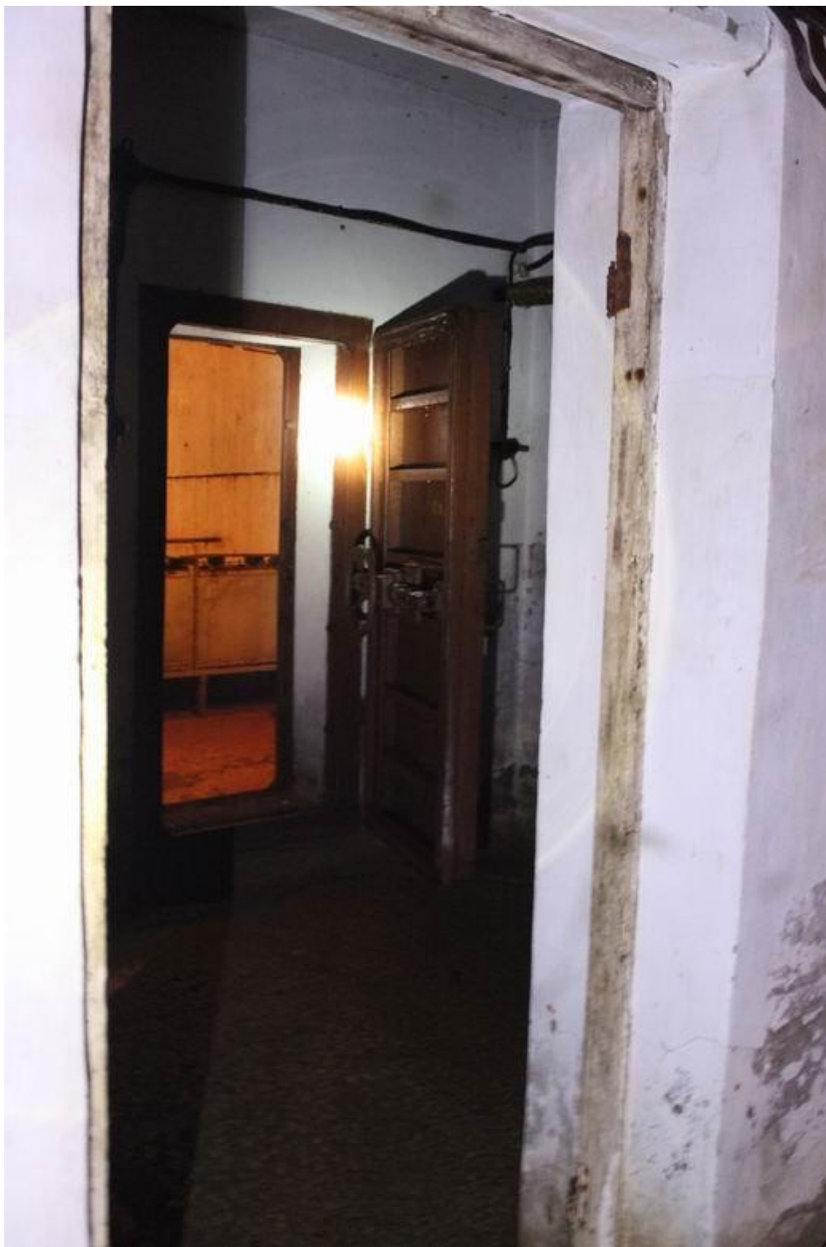
Рисунок Д.37 - Отсутствует дверное полотно в деревянной коробке в осях 4-5/Б. Поражение гнилью элементов дверной коробки
