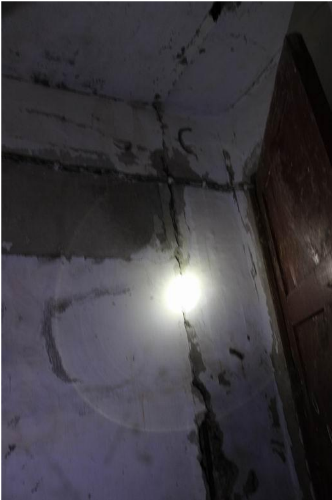
Рисунок Д.3 – Вертикальная трещина в месте сопряжения стены из бетонных блоков с монолитной стеной в осях 6.2/Б шириной раскрытия до 5,0мм. Выпадение раствора
