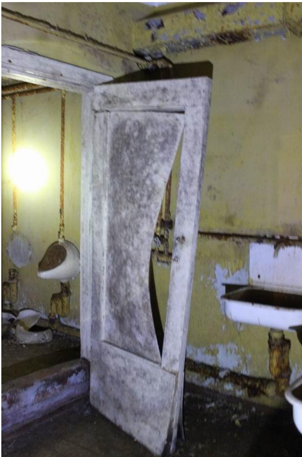
Рисунок Д.36 - Деформация и отслоение элементов деревянного дверного полотна в осях 1-2/А-Б. Поражение гнилью элементов дверного полотна и коробки
