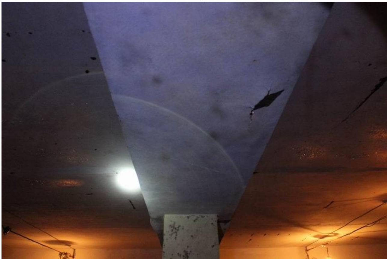
Рисунок Д.33 - Отслоение лакокрасочного слоя на нижней поверхности балки покрытия в осях 3/В-Г
