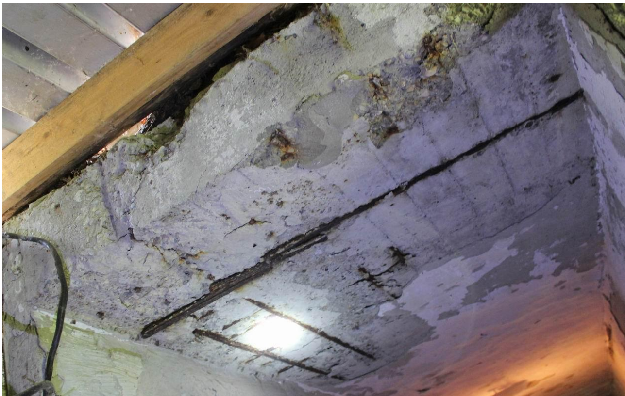
Рисунок Д.28 - Разрушение защитного слоя бетона на нижней поверхности плиты покрытия в осях 1.3-1.2/Д-Г
