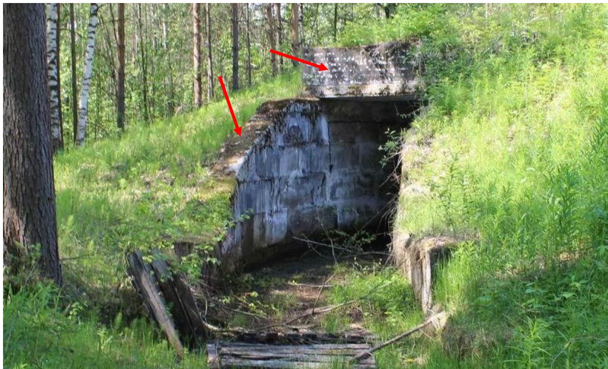
Рисунок Д.22 – Структурное разрушение бетонных блоков стены со стороны входа в коридор, ведущего с улицы к защитно-герметическим воротам на величину до 20 мм. Наличие мха на поверхности. Наличие уклона в сторону коридора, ведущего с улицы к защитно-герметическим воротам. Структурное разрушение цементно-песчаной стяжки по верху бетонных блоков. Частичное отсутствие (разрушение) обмазочной гидроизоляции
