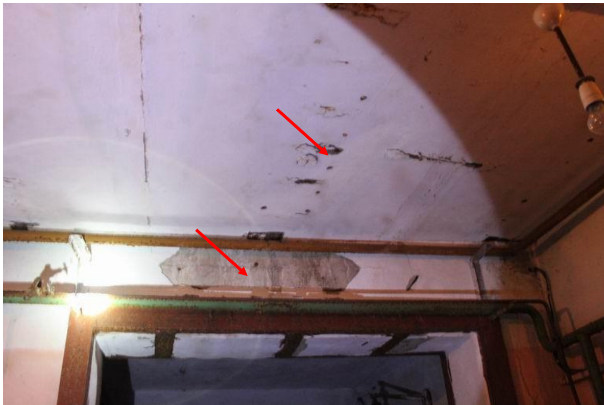
Рисунок Д.15 - Локальный участок с разрушением штукатурного слоя на внутренней поверхности стены на всю толщину в осях 6/В-Б. Отслоение и разрушение защитного слоя бетона на нижней поверхности плиты покрытия с оголением и коррозией арматуры
