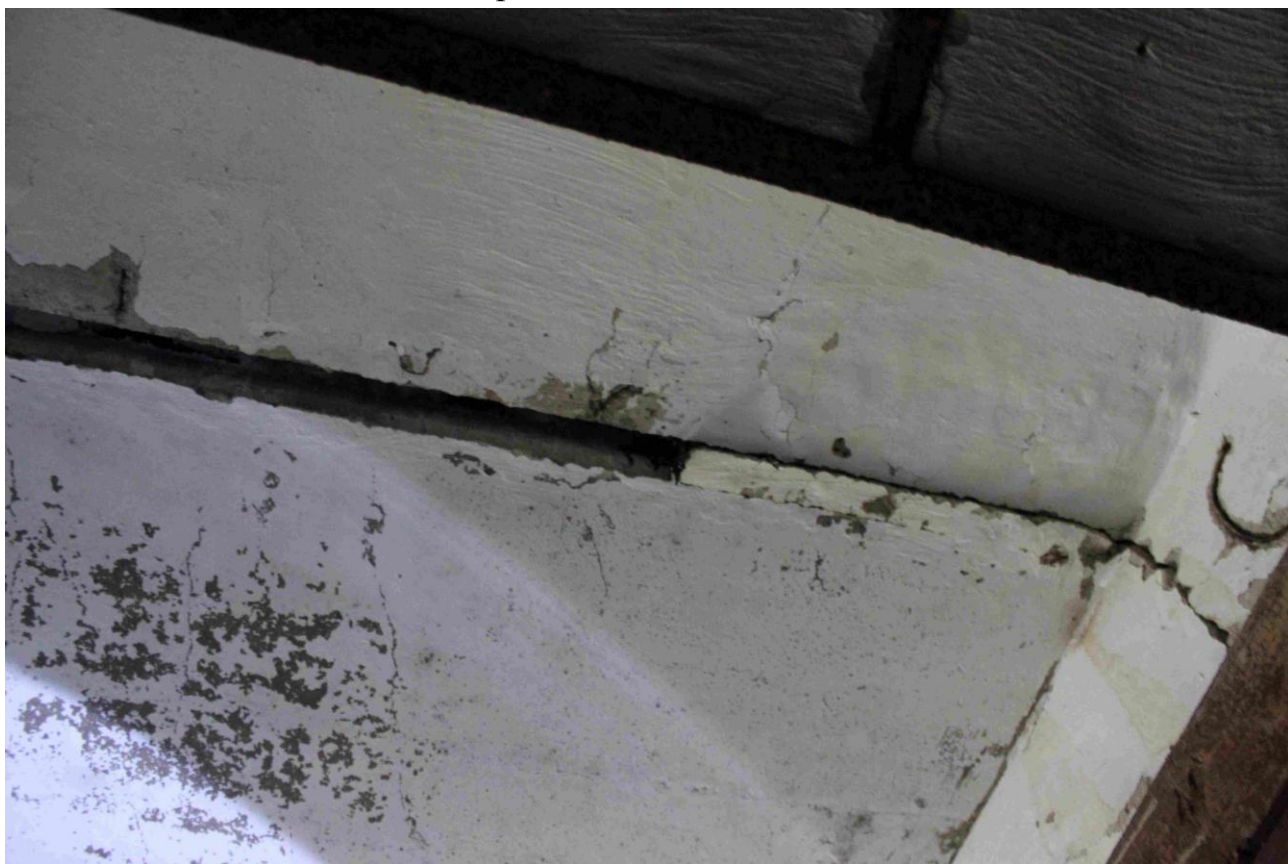
Рисунок Д.25 - Выкрошивание раствора из шва между сборной плитой и монолитной плитой покрытия в осях 6.2/Б-В
