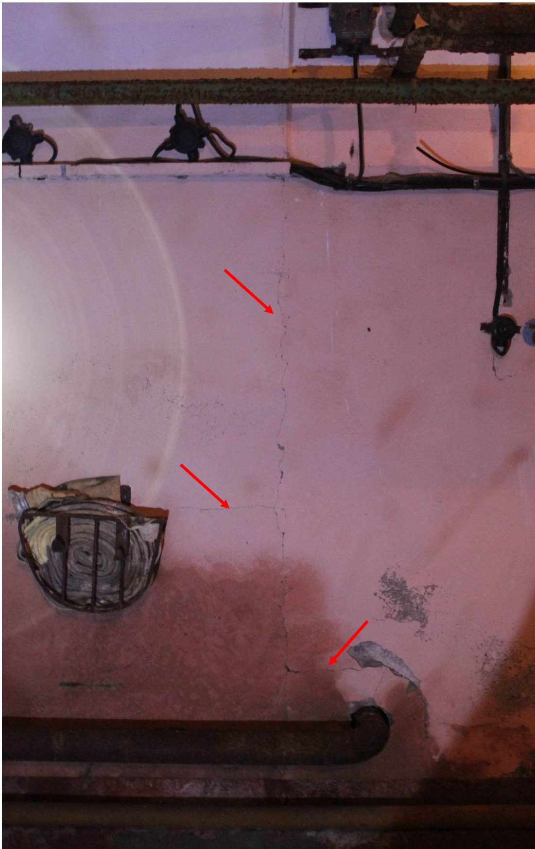
Рисунок Д.19 - Вертикальная и горизонтальные трещины на поверхности стены в осях 6-5/Б шириной раскрытия до 2,0 мм. Увлажнение на поверхности стены
