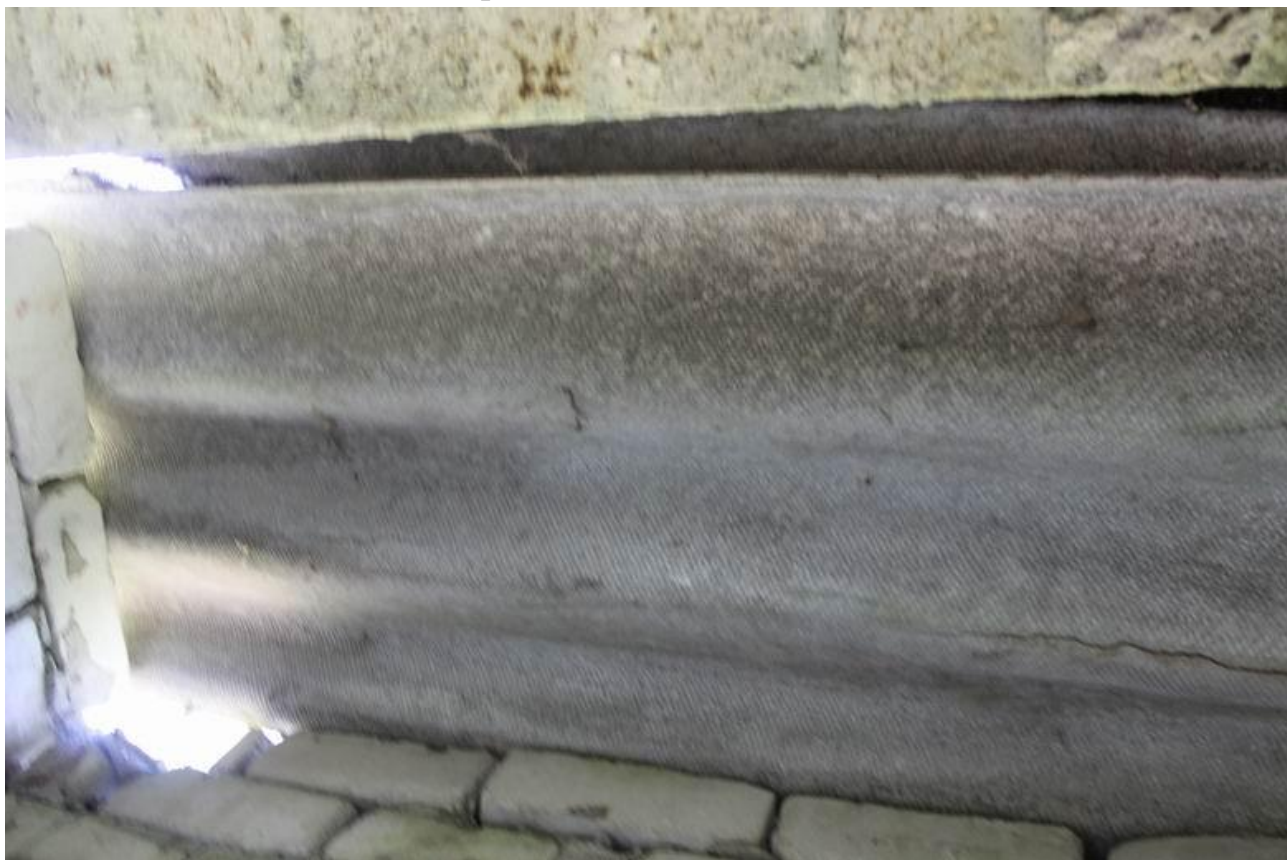
Рисунок Д.29 - Волнистый асбестоцементный лист покрытия в осях 1.3-1.2/А-Б уложен без обрешетки (несущая способность листа недостаточна для восприятия расчетных нагрузок)
