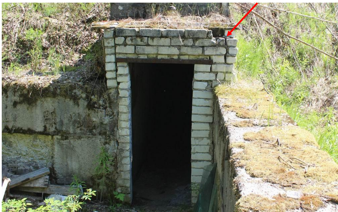
Рисунок Д.5 – Дефекты кирпичной кладки стены входа в убежище со стороны оси А: нарушена перевязка кирпичной кладки, пустошовка, не выдержана требуемая толщина швов кирпичной кладки (п.9.2.4 СП СП70.13330.2012), толщина кирпичной стены меньше минимально допустимого значения (п.9.20 СП 15.13330.2020), отсутствует один кирпич
