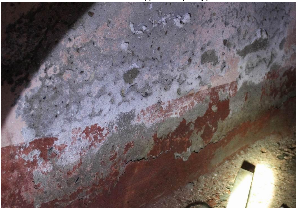
Рисунок Д.16 - Следы затопления убежища на поверхности внутренней стены в осях 5/Б-В. Шелушение и разрушение окрасочного слоя. Трещины в штукатурном слое
