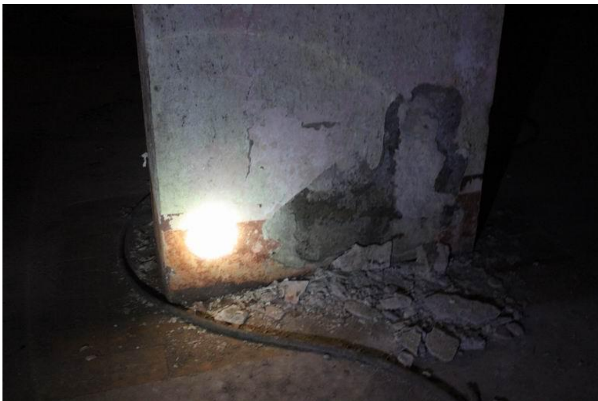
Рисунок Д.23 - Локальный участок с разрушением штукатурного слоя колонны в осях 3/Г
