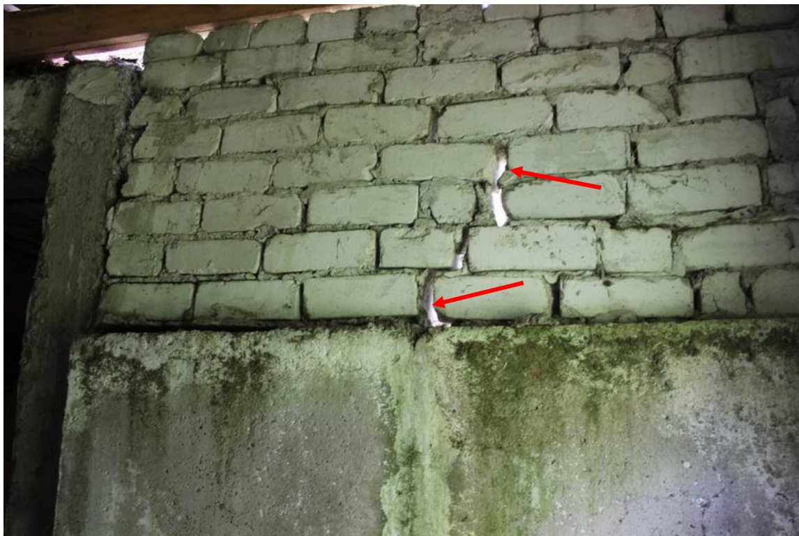
Рисунок Д.6 – Дефекты кирпичной кладки стены входа в убежище со стороны оси Д: нарушена перевязка кирпичной кладки, пустошовка, не выдержана требуемая толщина швов кирпичной кладки (п.9.2.4 СП СП70.13330.2012), толщина кирпичной стены меньше минимально допустимого значения (п.9.20 СП 15.13330.2020) ). Отсутствуют отдельные кирпичи. Трещины в кирпичной кладке шириной раскрытия до 15,0 мм. Частичное отсутствие (разрушение) обмазочной гидроизоляции
