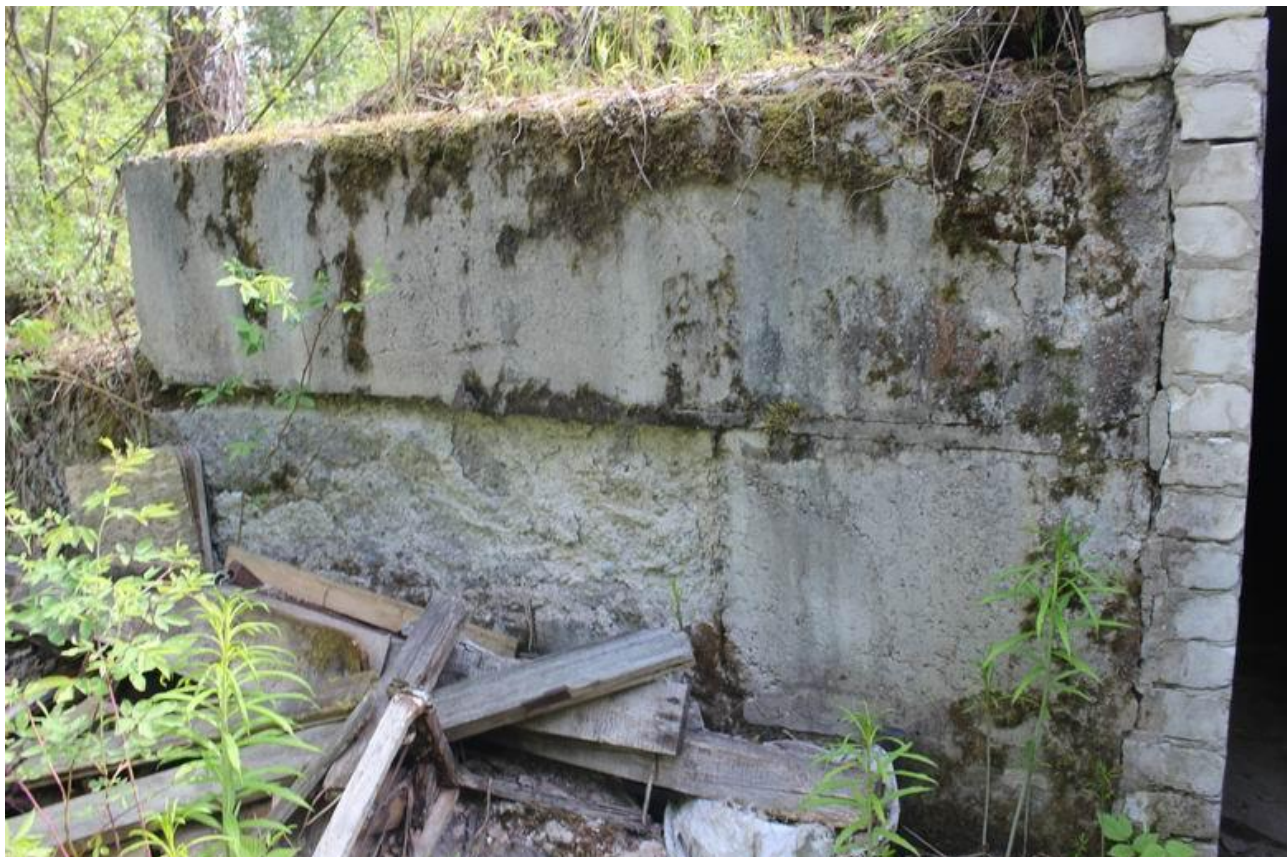
Рисунок Д.20 – Структурное разрушение бетонных блоков подпорной стены со стороны входа по оси А на величину до 40 мм. Наличие мха на поверхности
