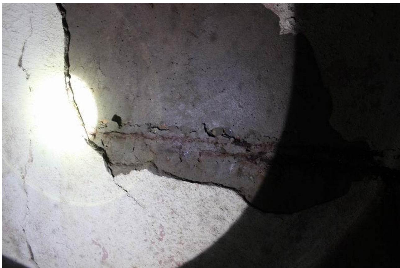
Рисунок Д.12 - Увлажнение на внутренней поверхности наружной стены в осях 2-3/Д. Локальные участки с разрушением штукатурного слоя. Отслоение и разрушение защитного слоя бетона
