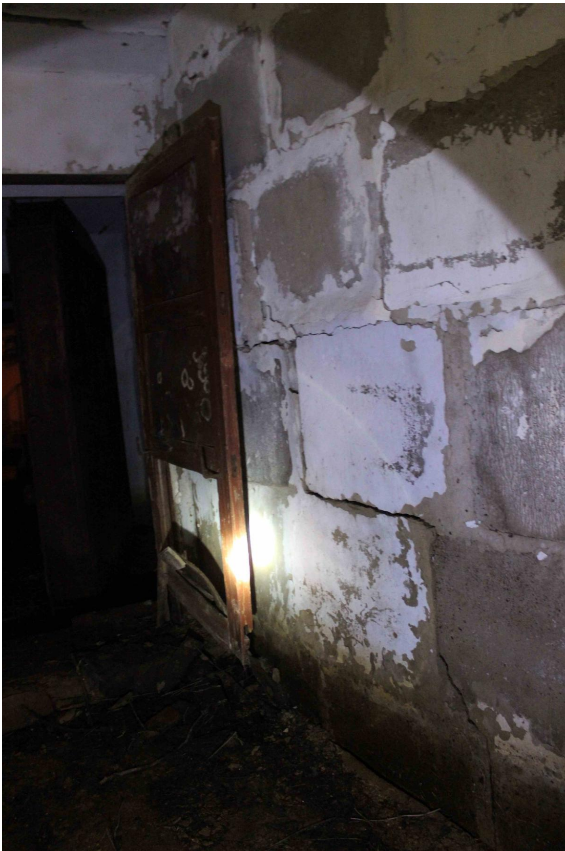
Рисунок Д.2 – Вертикальные и горизонтальные трещины в швах между бетонными блоками стены коридора в осях 6.2/Б-В (ближе к оси В) шириной раскрытия до 10,0мм. Поражение гнилью элементов дверного полотна, отсутствие участка дверного полотна
