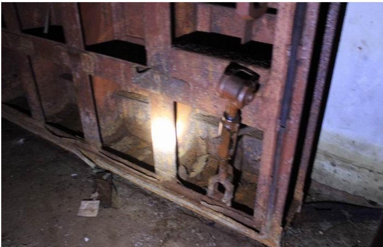
Рисунок Д.34 - Коррозия элементов стальных защитно-герметических ворот в осях 6/ Б-В с уменьшением площади поперечного сечения элементов на 5 %.
