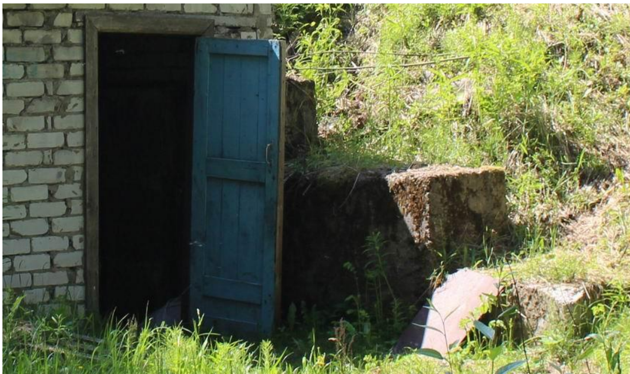
Рисунок Д.21 – Структурное разрушение бетонных блоков стены со стороны входа по оси Д на величину до 20 мм. Наличие мха на поверхности
