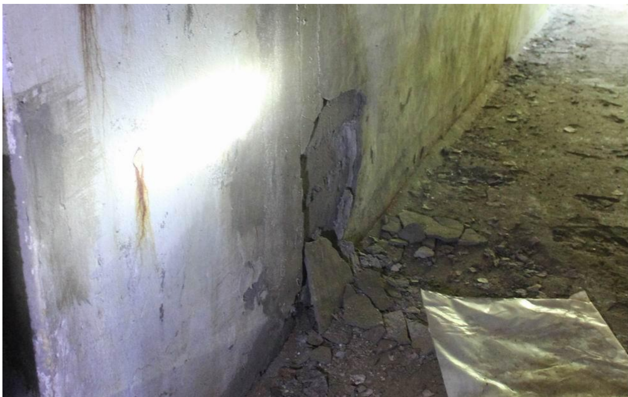
Рисунок Д.8 – Разрушение штукатурного слоя на внутренней поверхности наружной стены в осях 1.2/В-Б на площади около 0,5 м 2
