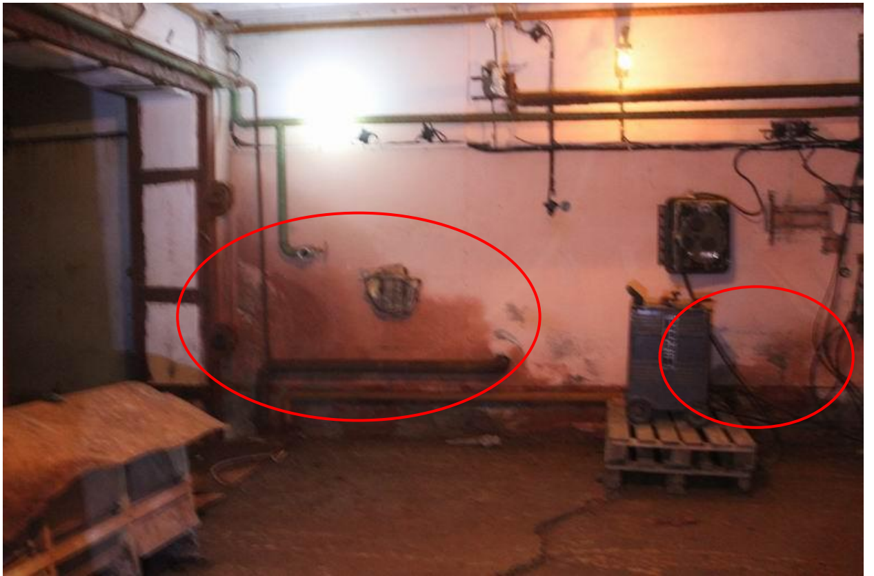
Рисунок Д.18 - Увлажнение на поверхности стены в осях 6-5/Б
