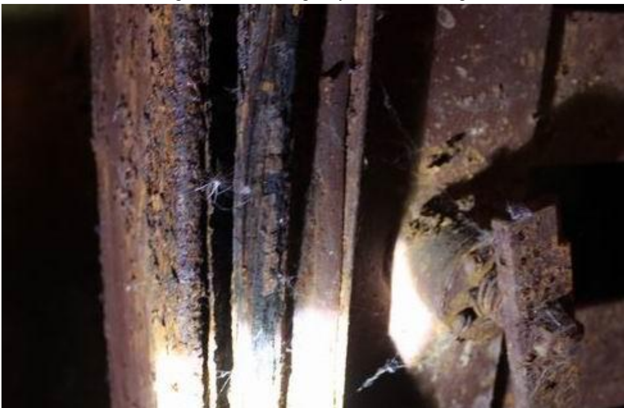
Рисунок Д.35 - Коррозия элементов стальных защитно-герметических дверей в осях 1.1/ Г с уменьшением площади поперечного сечения элементов на 5 %.
