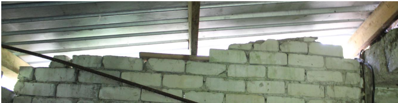
Рисунок Д.27 – Ненадежное крепление прогонов покрытия к кирпичной кладке в осях 1.3-1.2/Д. Центральный прогон (Пр 2) выполнен недостаточного поперечного сечения для восприятия расчетных нагрузок
