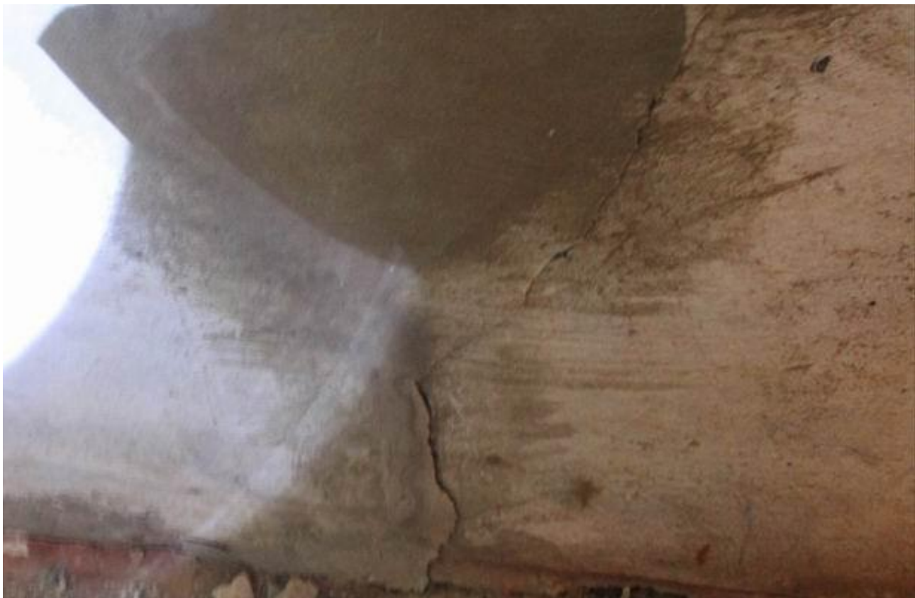
Рисунок Д.9 – Вертикальная трещина в стене в месте расположения вертикального деформационного шва в осях 1.2/Г шириной раскрытия до 5,0 мм.
