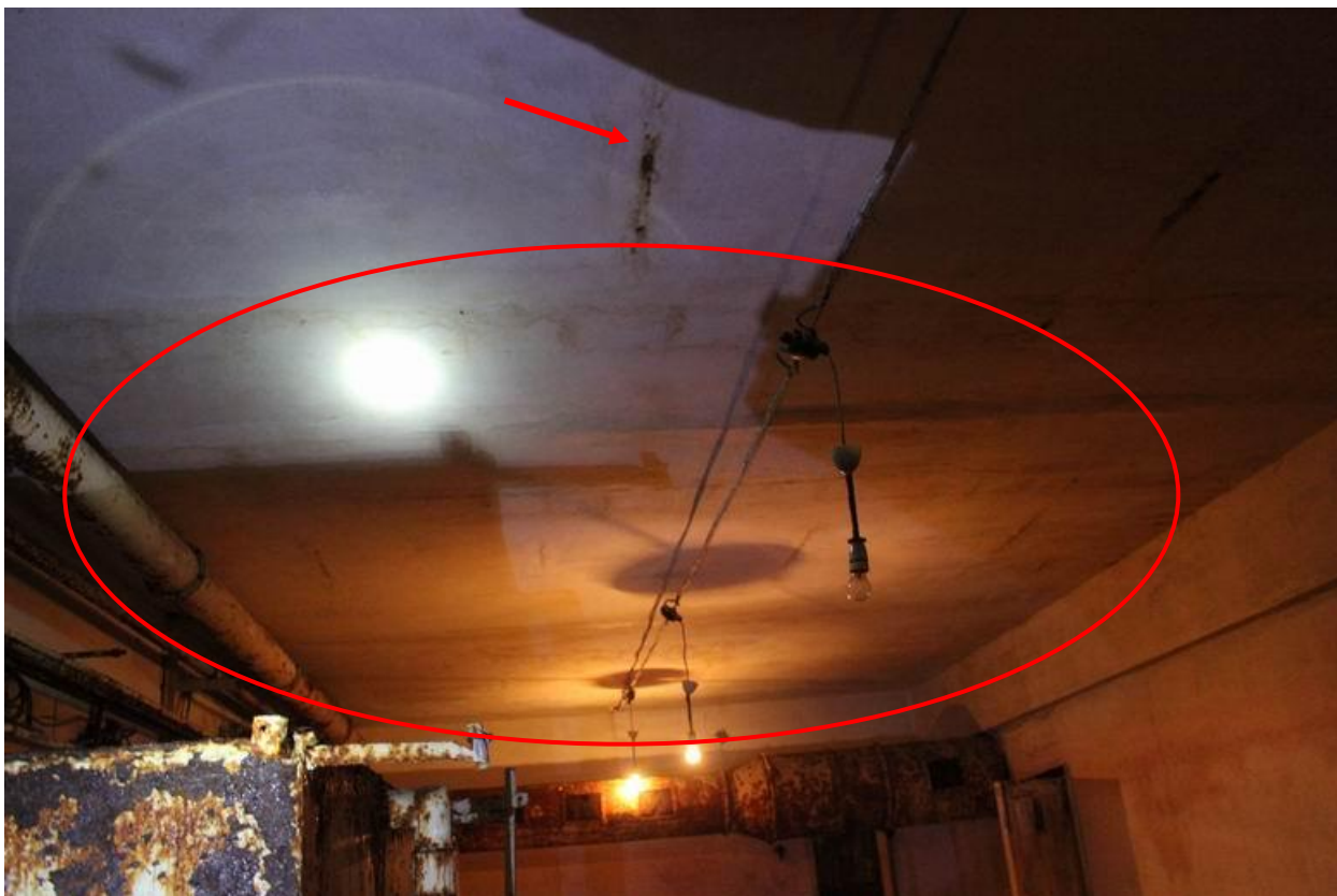
Рисунок Д.30 - Отслоение и разрушение защитного слоя бетона на нижней поверхности плиты покрытия в осях 1.3-1.2/Д-Г. Следы увлажнения на нижней поверхности плиты покрытия
